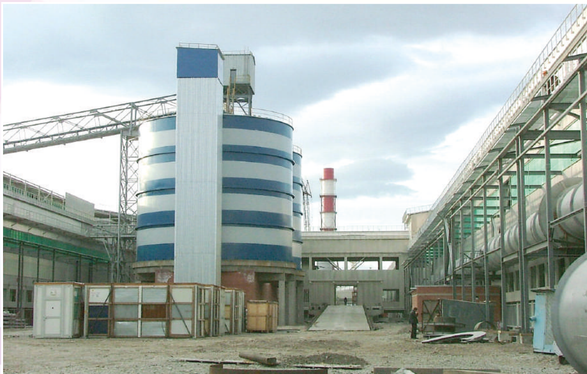
Корпус глинозёма и галерея подачи глинозёма
