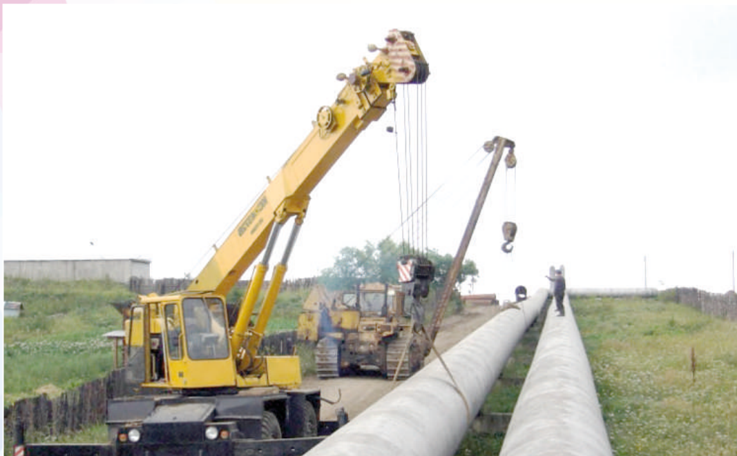
Монтаж нефтепровода D=1020, участок р. Каменка, г. Нижнеудинск
