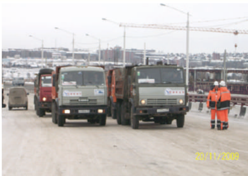
Испытания нагрузки мостовых сооружений
