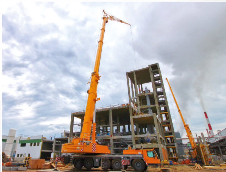
Возведение монолитного каркаса цеха приготовления диоксида хлора
