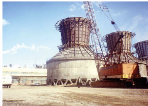
Реконструкция системы орошения градирни
