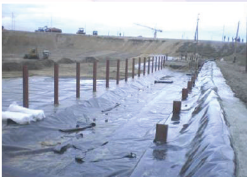
Устройство очистных сооружений, геомембрана
