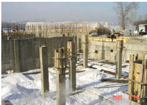
Зимнее бетонирование скважин
