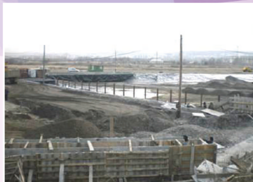
Устройство фундаментов здания очистных сооружений
