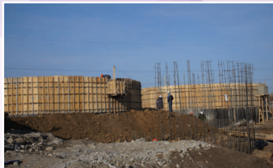
Строительство илоуплотнителей
