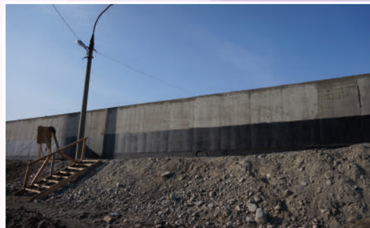
Готовая площадка временного хранения обезвоженного осадка
